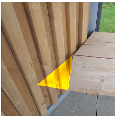
Suolas turėtų būti suvedamas su šonine sienie išvengiant tarpų
